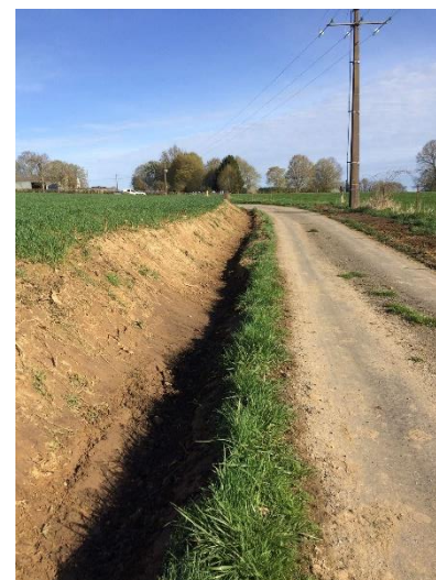
Figure 52. Exemple de reprofilage de fossé
