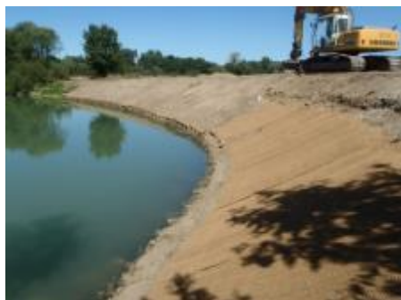
Aménagement de berge sur la commune de Pont-Arcy (2013)
