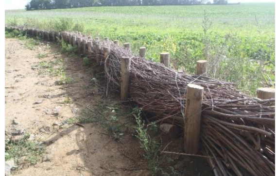
Figure 48. Exemple d'une fascine
